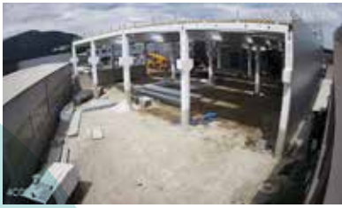
GRADNJA NOVEGA OBJEKTA, CESTA K TAMU 57
